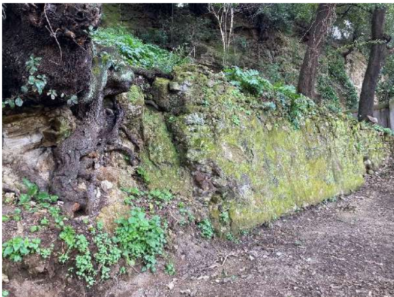
Figura 1-4 – Foto (in sequenza) del muro. Parte iniziale ad archi, albero centrale e parte finale con paramento subverticale.
