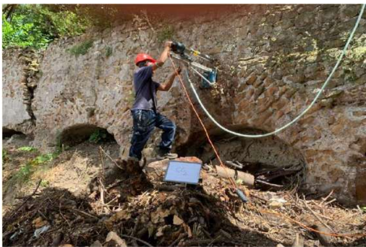
Figura 2-2 – Esecuzione di una delle perforazioni sul muro
