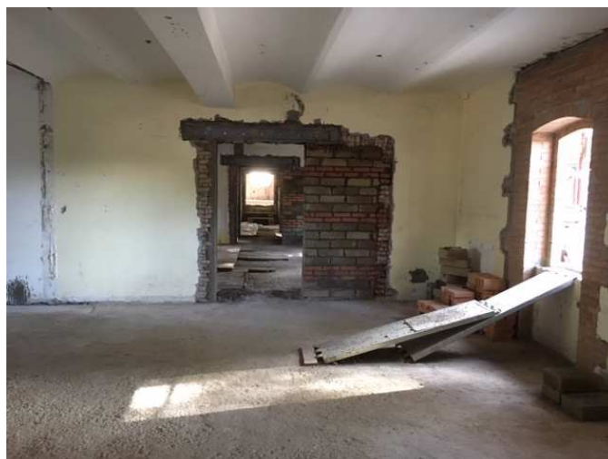
Casone B – premier étage Nouvelle circulation large sur toute la longueur du bâtiment éclairée naturellement en façade Sud
