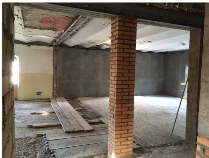
Casone C – premier étage A gauche du poteau : nouvelle salle des professeurs A droite du poteau : nouvelle salle de classe (récupérée dans La double hauteur de l'ancienne classe de Mme Musner
